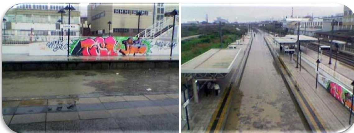
Ilustração 13 – Imagens da estação de Santa Iria (Linha do Norte) durante as inundações de 18 de Fevereiro de 2008.
