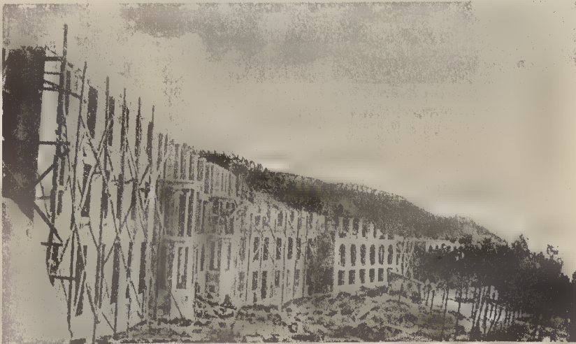
Sanatório da Covilhã — Uma fase da construção da fachada principal (18 de Setembro de 1932)
