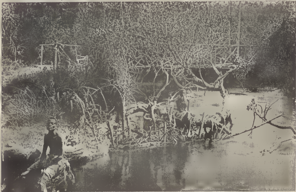
Lunda (Angola) — Ponte sôbre o rio Cuengo
