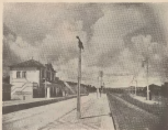
Contamil — Luz elétrica, lâmpadas de vapor de sódio, com 40 horas de duração, (Sociedade Saneamento)
