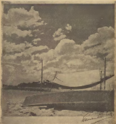
Questo bellissimo ponte di legno, a cura del Comune, è stato costruito in legno e di ferro da parte della Società Anonima del Ponte, progettato e costruito con la collaborazione
