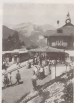
1.º CONGRESSO INTERNACIONAL DA FISAIC, REALIZADO EM BRUXELAS, EM 1954. À ESQUERDA, O PAVILHÃO DA FISAIC, À DIREITA, O PAVILHÃO DA C. P.
