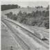
Estação de passageiros em São Paulo, com tração elétrica por meio de catenária de 600 V. O sistema é de corrente contínua.
